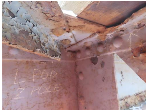
obr. č. 6: příčné ztužení, 2. pole – oslabení
