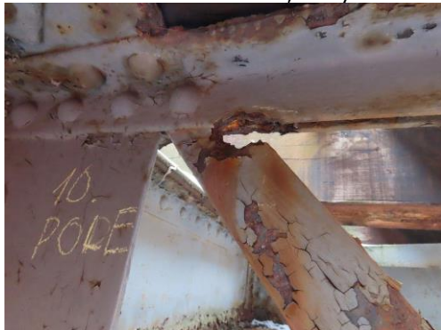
obr. č. 5: příčné ztužení, 10. pole – oslabení
